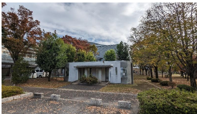
屋外トイレ(西側)
